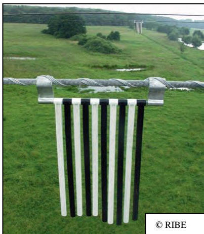
Figure 9-1: սև և սպիտակ կոշտ պլաստիկ ձողեր, որոնք ամրացված են և ձոճվում են ամպրապապաշտպան ճոպանի կամ հաղորդալարի վրա
