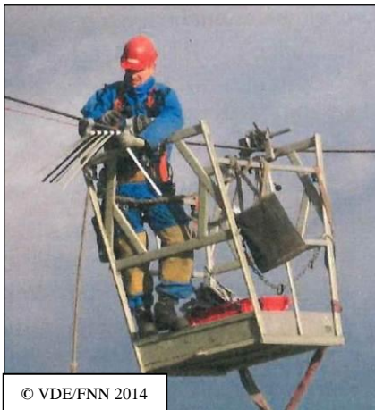
Պատկեր 9-2: Թռչունների անվտանգության հարմարանքների տեղադրում՝ օգտագործելով գծային մեքենա (ձախ) կամ գծային հեծանիվ (աջ)
