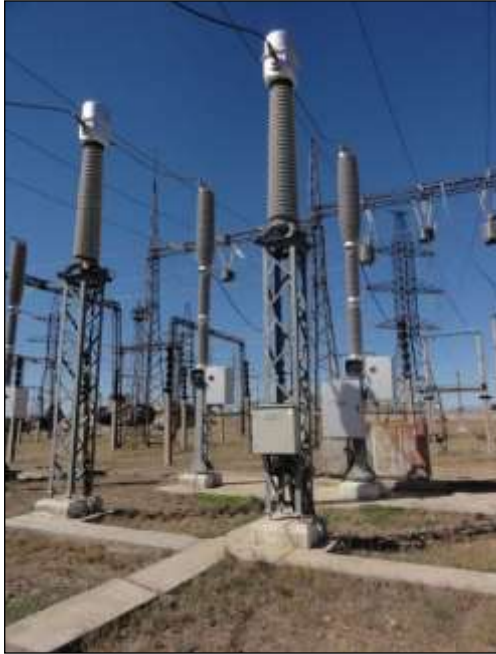
Լուսանկար 3-3: 2010թ.-ին տեղակայված SF 6 ավտոմատ անջատիչները Աշնակի ենթակայանում
