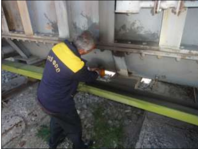
Լուսանկար 4-7 ՝ Յուղի փորձանմուշների վերցնելը տրանսֆորմատորից Աշնակի ենթակայանում
