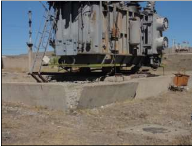
Լուսանկար 3-1: տրանսֆորմատորի շուրջ հիմքապատնեշը ջարդված է Աշնակակի ենթակայանում
