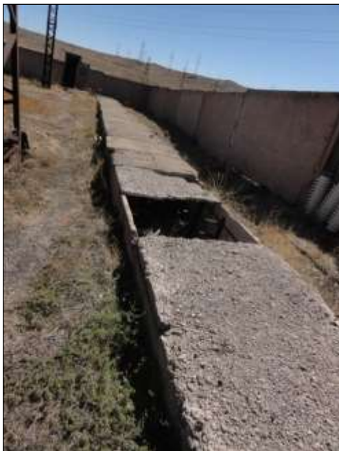
Լուսանկար 4-1՝ Վատ սպասարկված մալուխագծեր Աշնակի ենթակայանում
