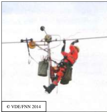
Պատկեր 9-2: Թռչյունների անվտանգության հարմարանքների տեղադրում՝ օգտագործելով գծային մեքենա (ձախ) կամ գծային հեծանիվ (աջ)
